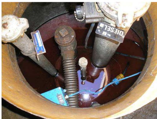
Domschacht voll Wasser / Flüssigkeit ✗
