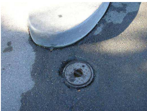
undichter Bereich um Schacht
