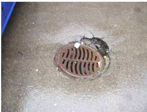
flächige Beschädigungen bei Einlaufschacht
