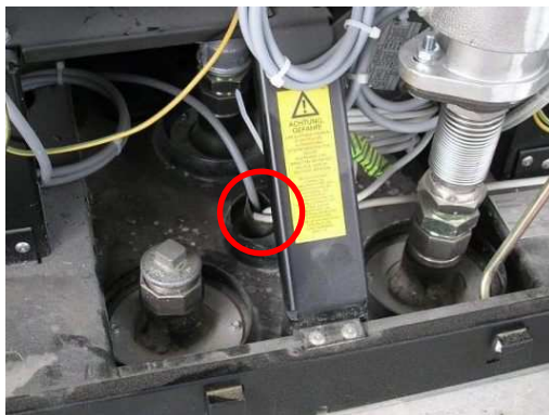
Säulenfuss nicht abgedichtet (Elektrokabel)
