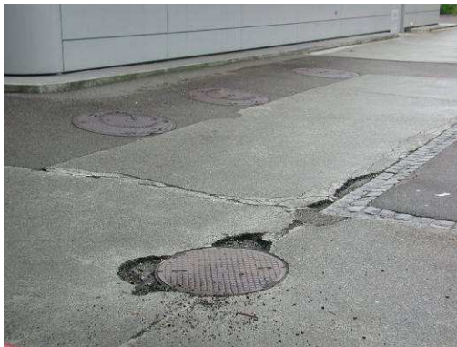
flächige Beschädigungen auf Umschlagplatz
