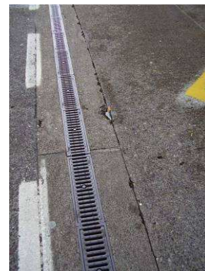
undichte Fuge vor Entwässerungsrinne
