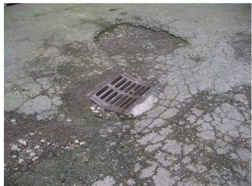
grossflächige Beschädigung bei Einlaufschacht
