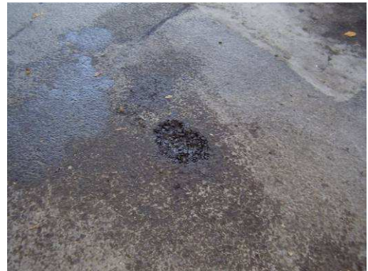
flächige Beschädigung auf Betankungsplatz
