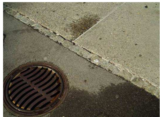
undichte Fuge Übergang Beton-Asphalt
